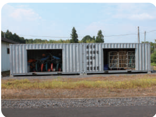
災害用資機材を保管するコンテナを設置しました。
