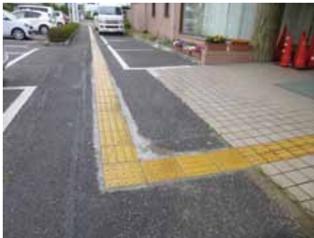
△施設内点字ブロック修繕工事
