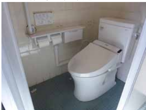
△トイレの洋式化工事
