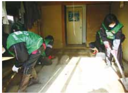
床板をはがす
